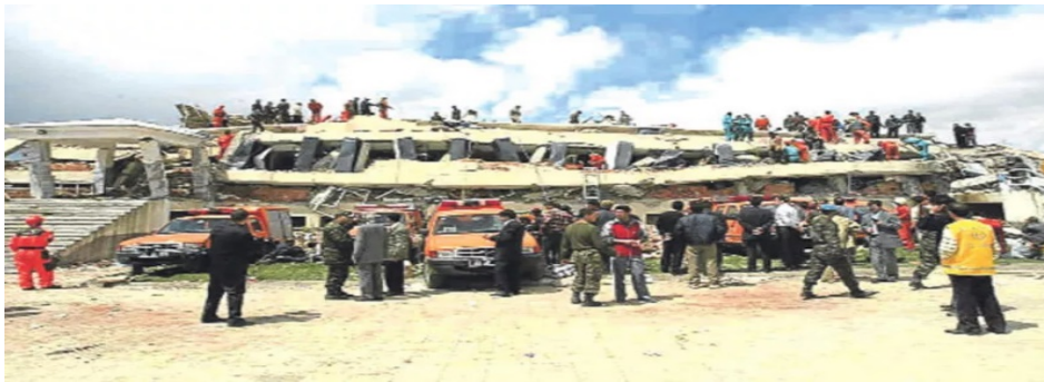
Şekil 2: Çeltiksuyu YİBO Binası Yıkılma Görüntüsü ( https://www.milliyet.com.tr/ )
